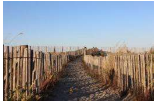
Risorsa 6 : Assestamentu dolce in palancati ( ganivelles ) à nantu à un terraniu di u Cunservatoriu di u Litturale di a Marana
